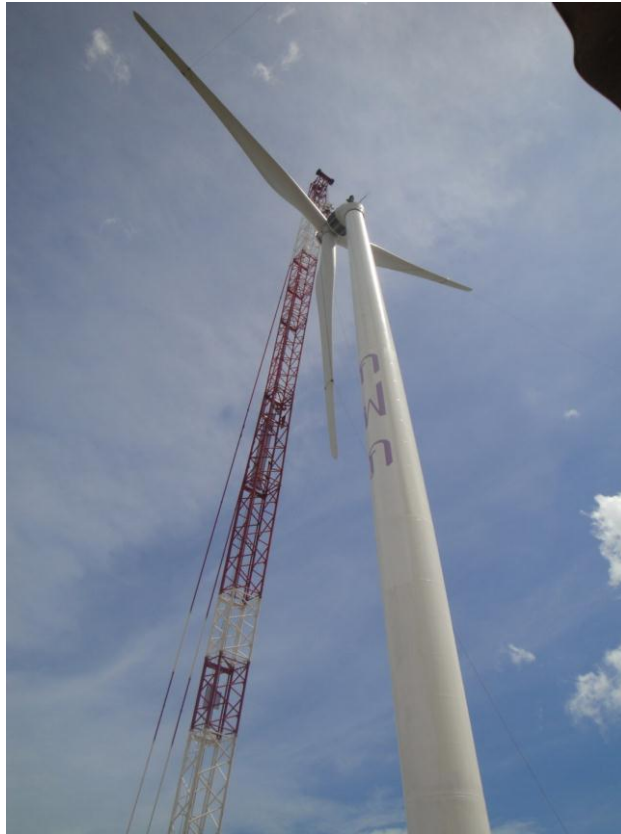
รูปที่ 1 ภาพแสดงการติดตั้งกังหันลม
