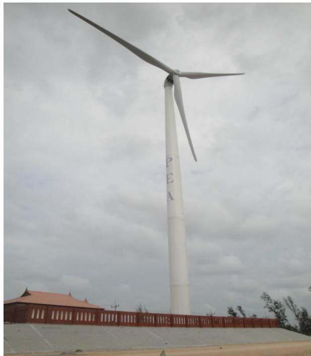
รูปที่ 4 ภาพการติดตั้งกังหันลมแล้วเสร็จ
