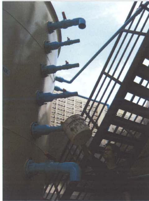
รูปที่ 4-33 แสดงจุดเก็บตัวอย่างน้ำในถังหมักก๊าซชีวภาพ Digester
