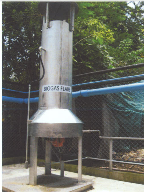
รูปที่ 5-5 ระบบเผาก๊าซส่วนเกิน (Biogas Flare)
