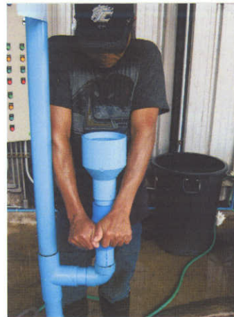
2. ค่อยๆเปิดวาล์วลื่อน้ำเพื่อไล่อากาศ
