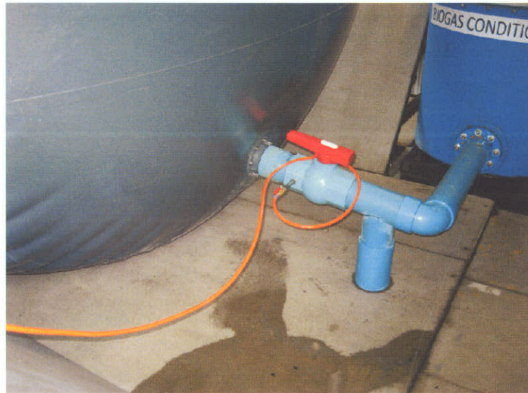
รูปที่ 4-26 แสดงสภาพวาล์วเข้าบอลลูนเก็บก๊าซชีวภาพ
