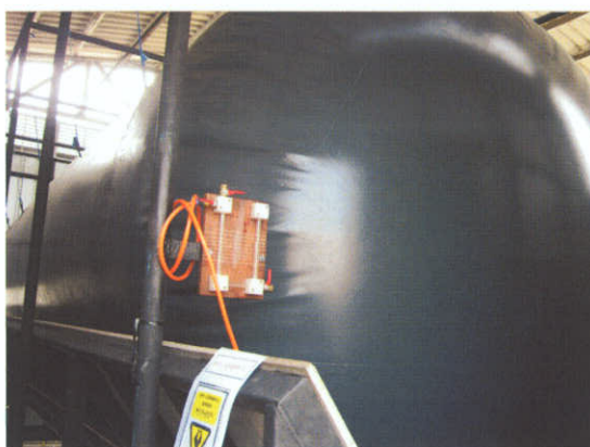
รูปที่ 5-3 แสดงบอลลูนเก็บก๊าซชีวภาพ
