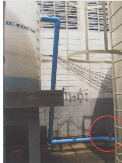
รูปที่ 4-30 แสดงสภาพวาล์วจากถังหมักก๊าซชีวภาพเข้าถังเก็บตะกอนส่วนเกิน
