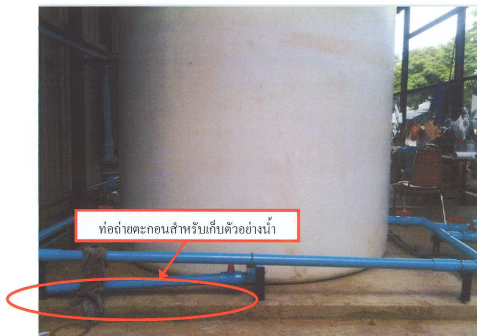
รูปที่ 4-32 แสดงจุดเก็บตัวอย่างน้ำในถังหมักกรด (Hydrolysis Tank)
