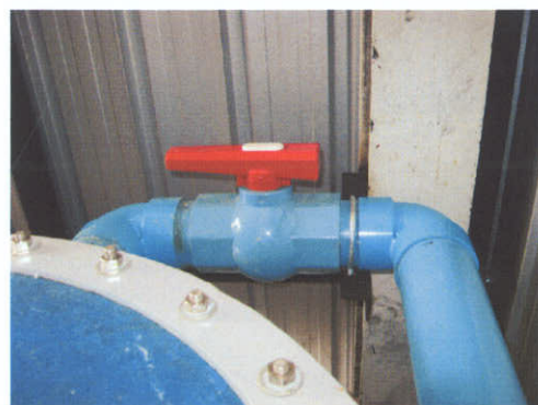
รูปที่ 4-25 แสดงสภาพวาล์วเข้าถังกำจัดก๊าซไฮโดรเจนซัลไฟด์
