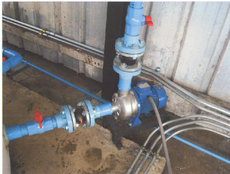
รูปที่ 4-22 แสดงสภาพวาล์วในเครื่องสูบขยะในถังหมักกรดเข้าถังหมักก๊าซชีวภาพ
