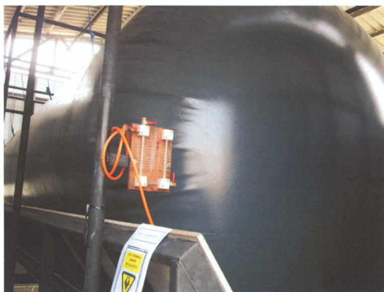
รูปที่ 3-11 บอลลูนเก็บก๊าซชีวภาพ (Biogas Holder)
