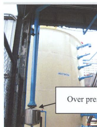
รูปที่ 4-27 แสดงสภาพวาล์วจากบอลลูนเก็บก๊าซไปยัง Over pressure
