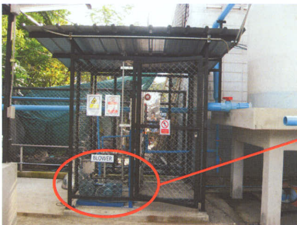
รูปที่ 5-6 แสดงระบบเพิ่มแรงดันก๊าซ (Biogas Blower)
