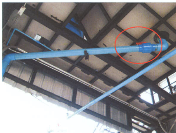
รูปที่ 4-27 แสดงสภาพวาล์วจากบอลลูนเก็บก๊าซไปยัง Over pressure
