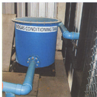
รูปที่ 4-25 แสดงสภาพวาล์วเข้าถังกำจัดก๊าซไฮโดรเจนซัลไฟด์
