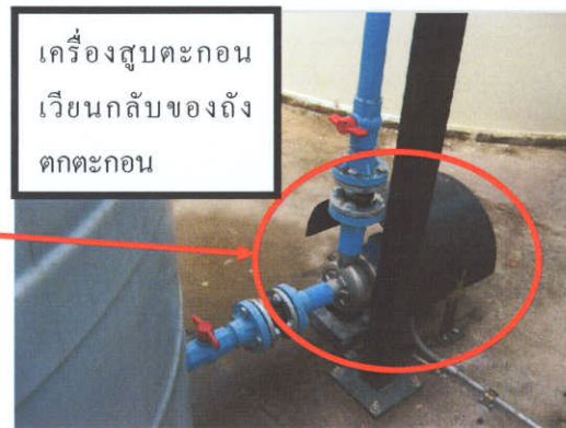
รูปที่ 4-18 แสดงขั้นตอนการเปิดสวิตช์เครื่องสูบน้ำเวียนกลับ
