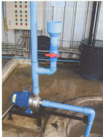
1. ตรวจสอบวาล์วลื่อน้ำของเครื่องสูบขยะอินทรีย์
