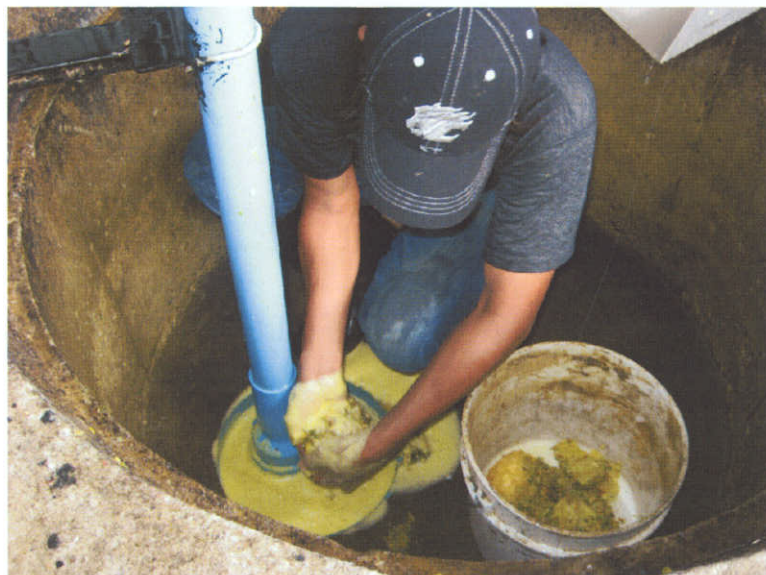
รูปที่ 4-14 แสดงน้ำที่เหลือค้างอยู่ในบ่อสูบ และการทำความสะอาดโดยการตักออก
