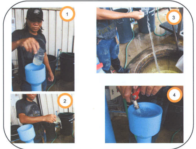
4. ตักน้ำขยะที่ล้นออกมาใส่กลับในบ่อสูบ และเติมน้ำสะอาดลงไปให้เต็มท่อ
