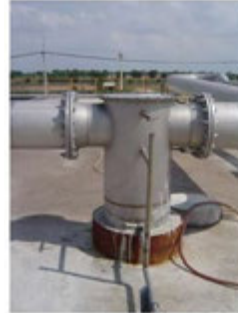
รูปที่ 2.3 ระบบดักละอองน้ำแบบ Knock out Drum
