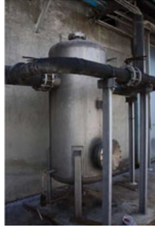
รูปที่ 2.3 ระบบดักละอองน้ำแบบ Knock out Drum
