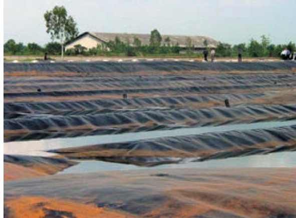
รูป 4 ระบบ Anaerobic Baffle Reactor (ABR)
