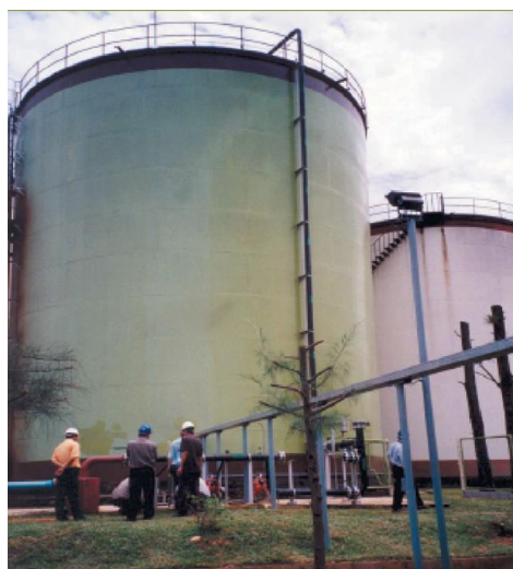
รูป 3 ระบบ Completely Stirred Tank Reactor (CSTR)
