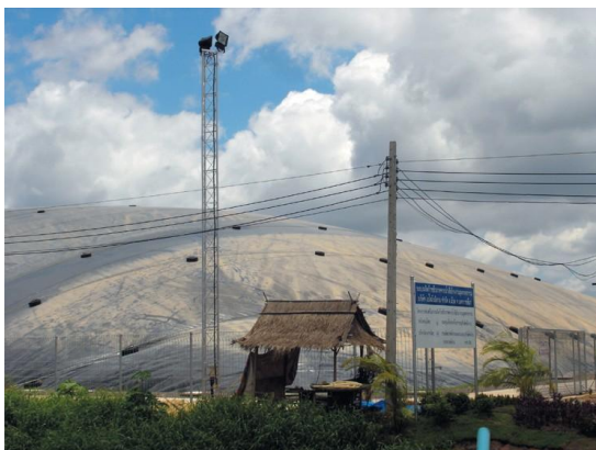
รูป 5 ระบบ Modified Covered Lagoon (MCL)
