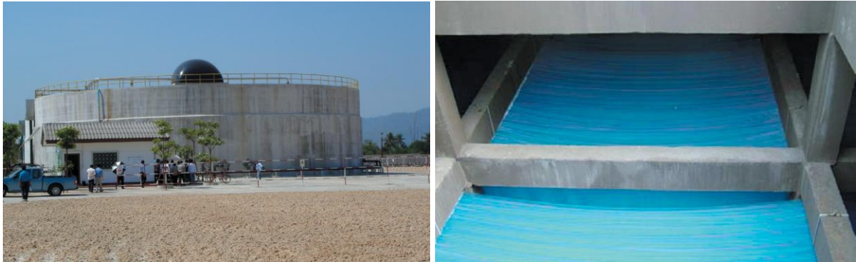
รูป 2 ระบบตรึงฟิล์มจุลินทรีย์ (Anaerobic Fixed Film, AFF)
